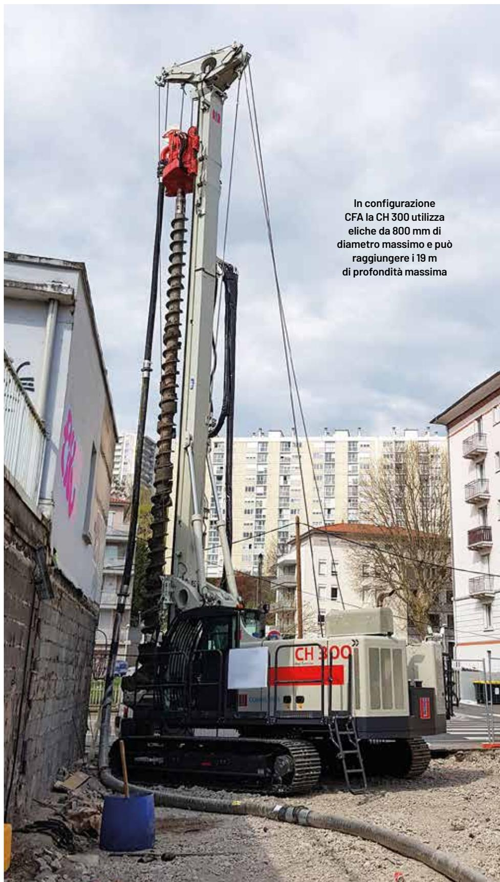
In configurazione CFA la CH 300 utilizza eliche da 800 mm di diametro massimo e può raggiungere i 19 m di profondità massima
