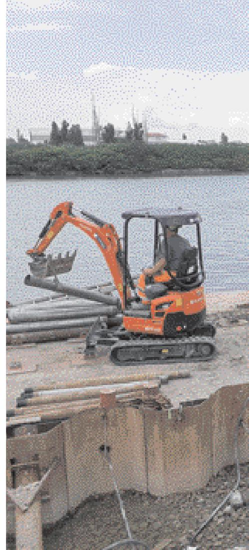
4-5 ore era possibile procedere con l’iniezione tramite il tubo valvolato arrivando a pressione alla rottura della guaina”, spiega il Geom. Zuglian. “Avevamo a disposizione un iniettore idraulico e un turbo miscelatore per confezionare la miscela, per l’iniezione di seconda fase abbiamo utilizzato un doppio parker a calottine. Terminata la maturazione della miscela i tiranti sono stati sottoposti a tesatura come da norme UNI EN 1537/2002 e sigillati”.
