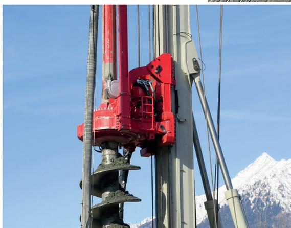
Il terreno è particolarmente inconsistente e tende a collassare sull'elica. Da notare l'utilizzo dell'escavatore per preservare l'area di lavoro
