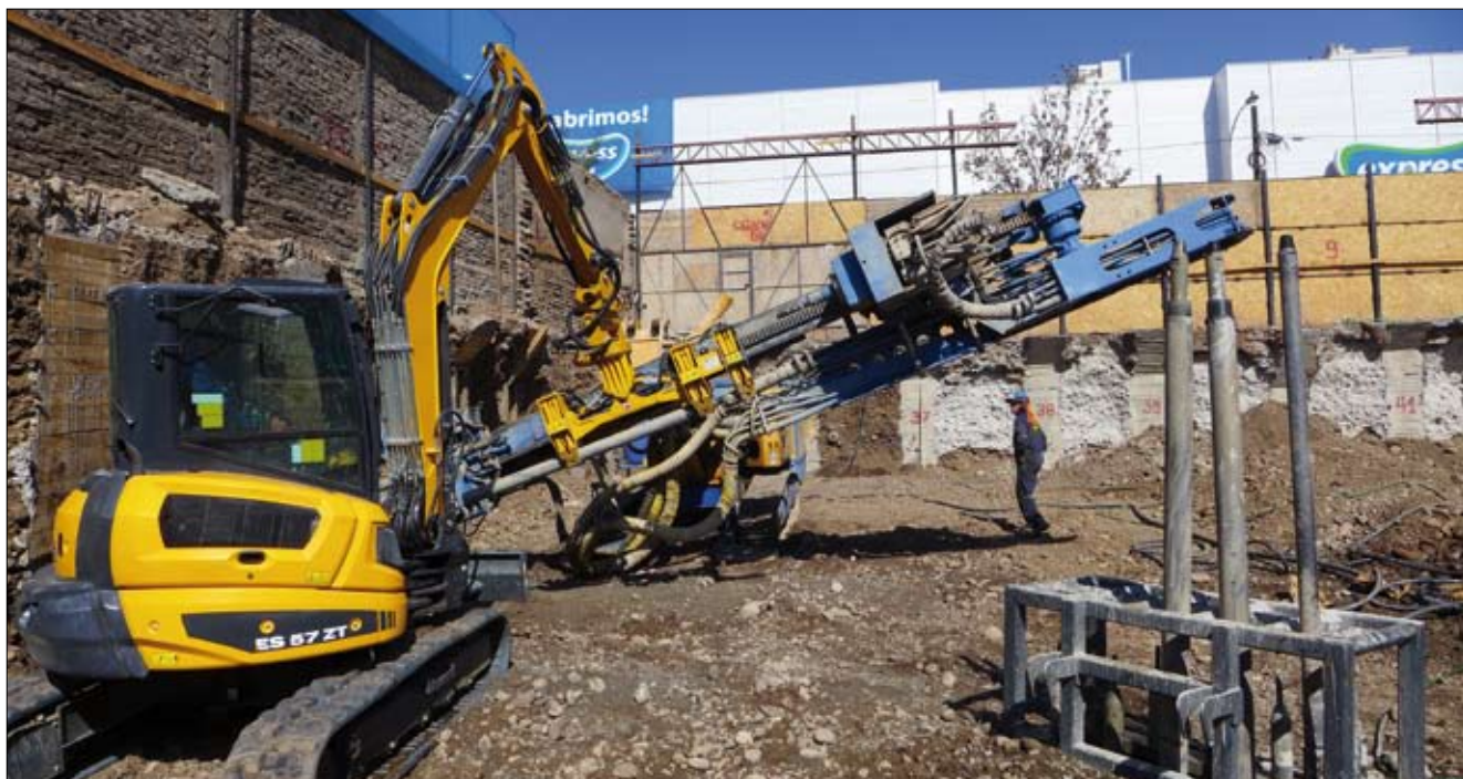
Il manipolatore per aste e rivestimenti montato su escavatore CPH è stato sviluppato per facilitare le operazioni di carico/scarico dell'attrezzatura in cantiere. Nella foto, è al lavoro in cantiere insieme a una perforatrice Comacchio MC 8
