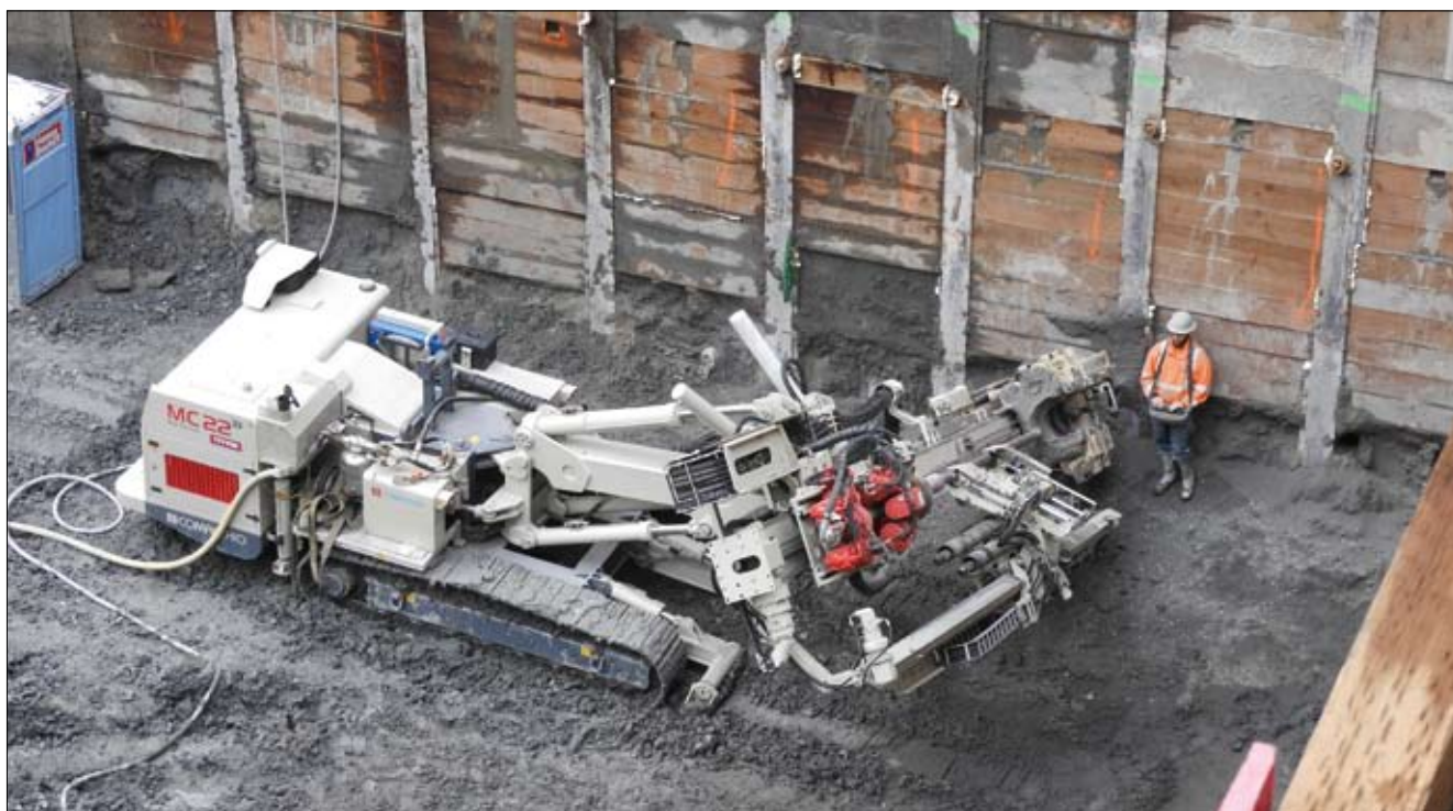
La MC 22 A, perforatrice dotata di un innovativo caricatore automatico per aste e rivestimenti che elimina la necessità di movimentazione manuale delle attrezzature
