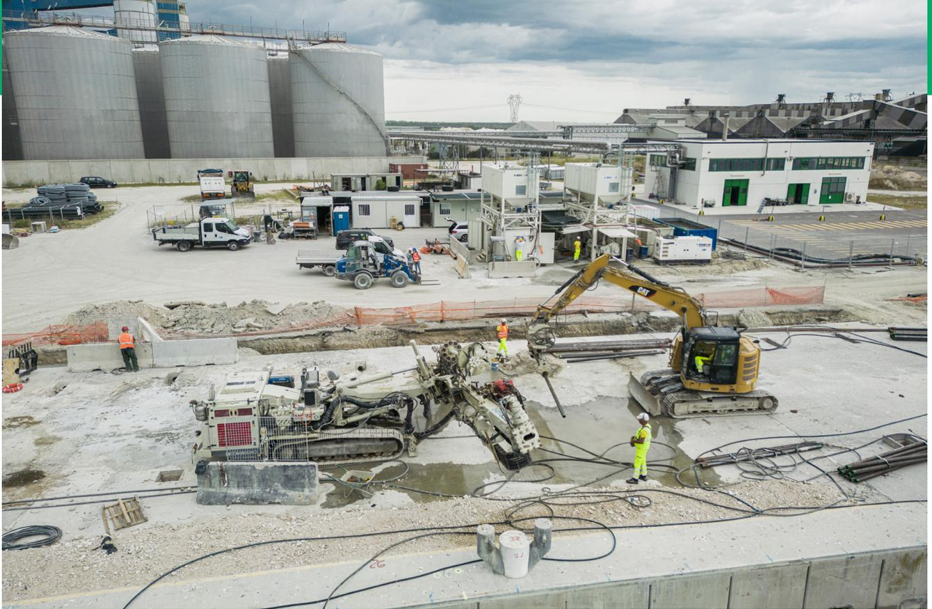
che stiamo completando con la Comacchio MC 22, all'inizio procediamo con una perforazione effettuata esclusivamente con acqua, a 50 bar. La perforatrice avanza con teste a due ugelli - uno inclinato a 50° e il secondo a 90° - che procedono in
