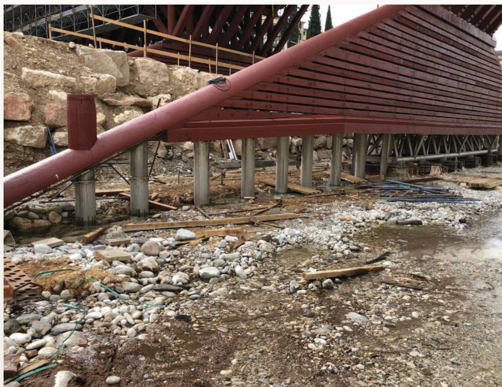
vernali: nel periodo compreso tra dicembre e aprile, infatti, il livello dell'acqua scende e rende possibile l'allestimento delle cosiddette "ture", delle opere provvisorie poste nell'alveo a valle del ponte, che permettono di prosciugarlo in corrispondenza delle stilate, formando delle penisole per contenere e rendere accessibile il cantiere.
