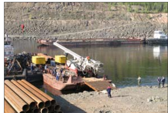
The Comacchio drill rig MC 3000 is loaded on the barge / Погрузка на баржу буровой установки Comacchio MC 3000
