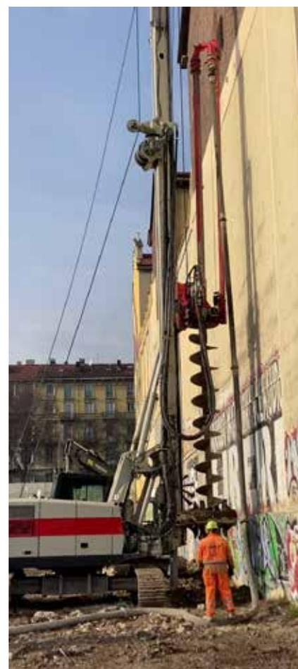
> La perforatrice Comacchio CH 450 in forza a TERRA.CON, in versione CFA, utilizzata qui per la realizzazione di una paratia esterna perimetrale in pali CFA di diametro 600 mm, a una profondità che raggiunge i 15 m, e di diametro 1.000 mm fino a una lunghezza massima di 17 m
